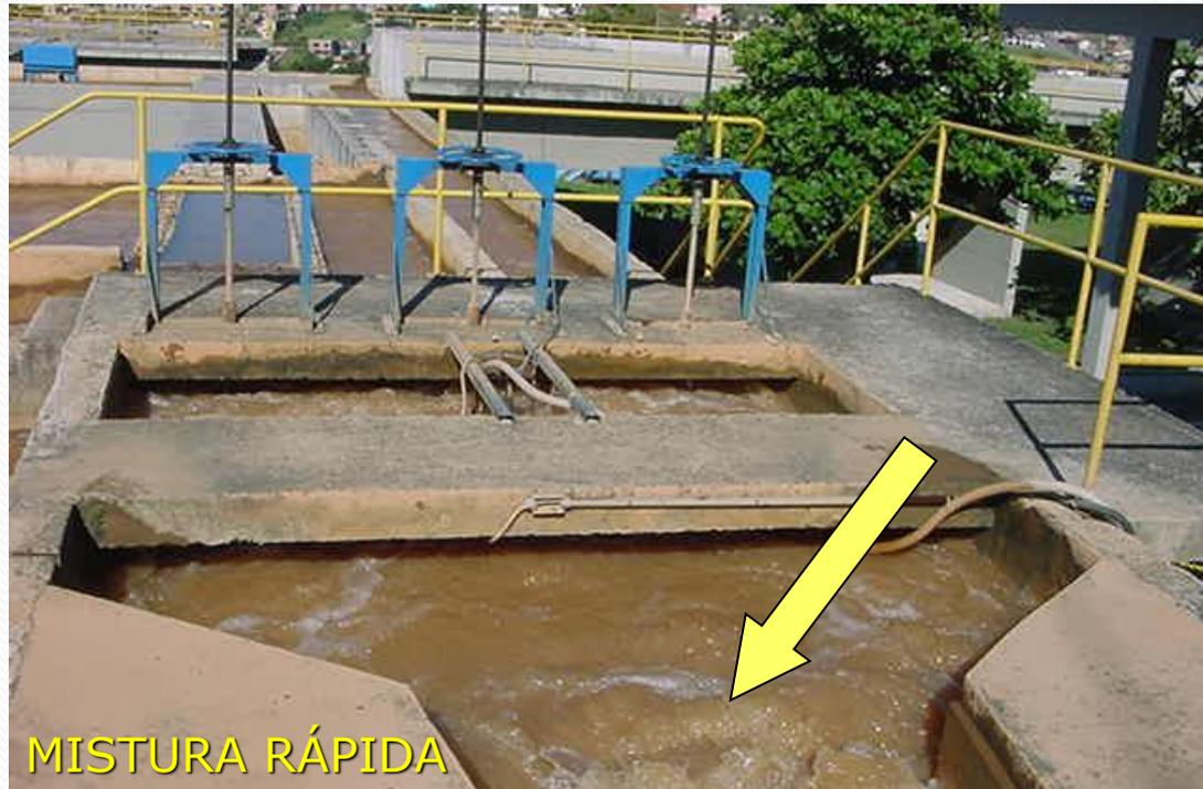
Nesta fase, é adicionado sulfato de alumínio, cloreto férrico ou outro coagulante, seguido de uma agitação violenta da água. Assim, as partículas de sujeira ficam eletricamente desestabilizadas e mais fáceis de agregar.
