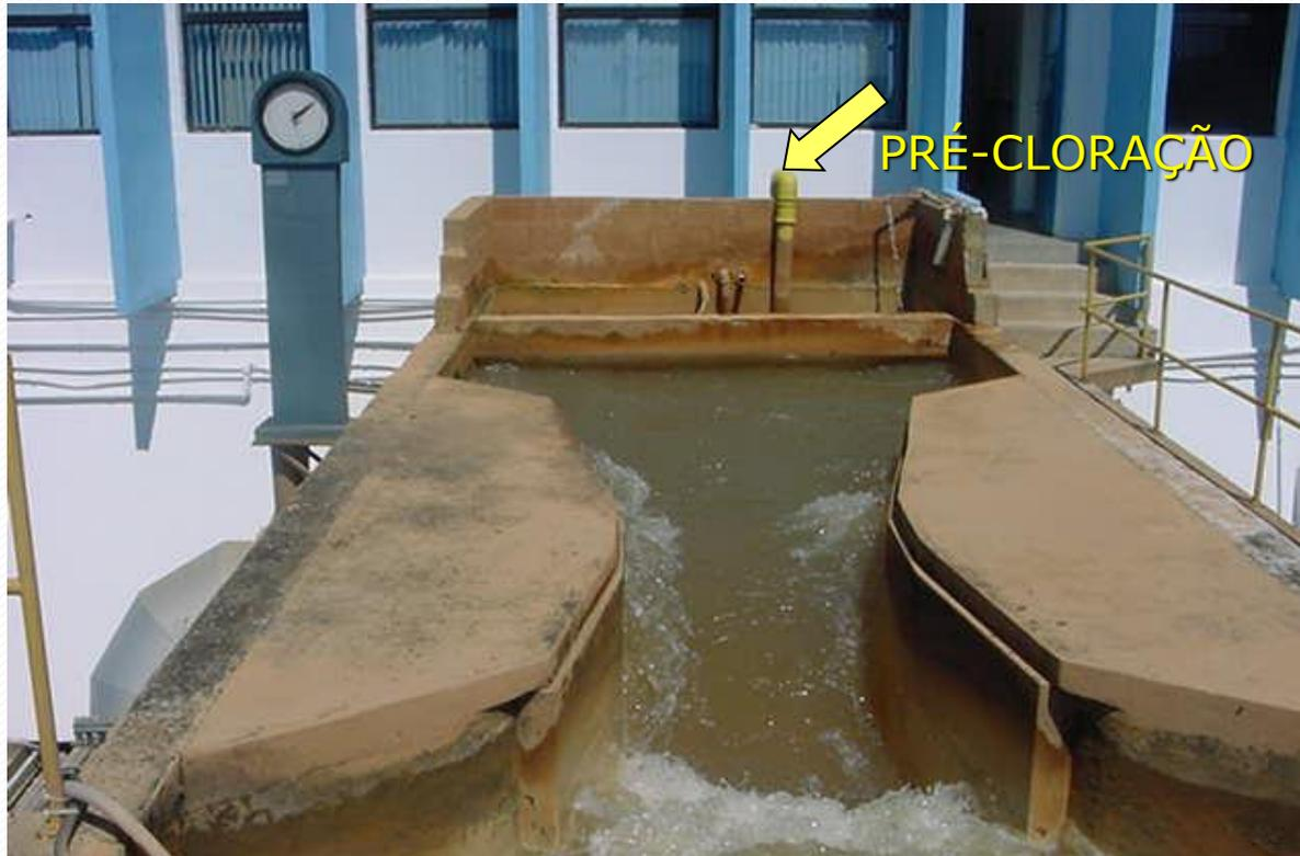
Primeiro, o cloro é adicionado assim que a água chega à estação. Isso facilita a retirada de matéria orgânica e metais.
