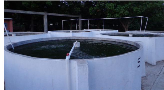
Figura 11. Estanque de ferrocemento.
